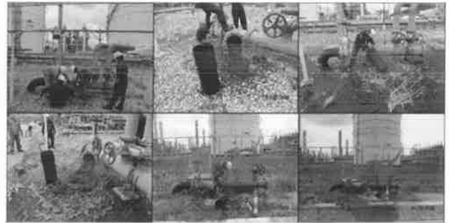
Flush Line Fire Water และ Clean Strainer Deluge System
