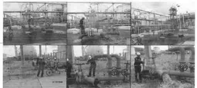
Flush Line Fire Water และ Clean Strainer Deluge System
